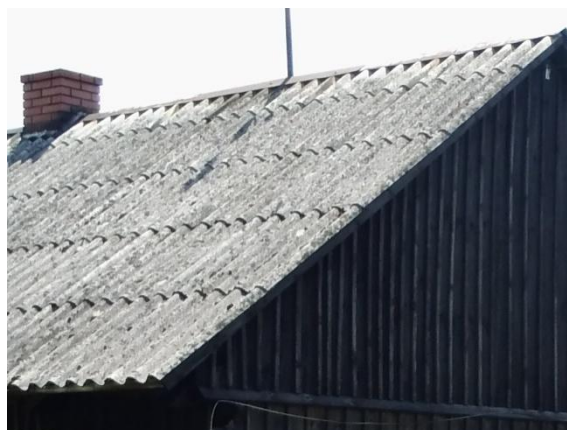
Rysunek 1. Pokrycia dachowe zawierające azbest: płyty płaskie (po lewej) oraz faliste (po prawej) [źródło: materiały własne]
